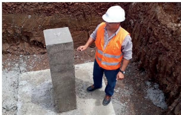
En presa de tierra de margen derecha se instalaron dos freatómetros de apoyo a los actualmente existentes (piezómetros, pozos de observación y freatómetros), con el fin de ampliar la información disponible para el análisis del comportamiento de la presa de tierra.
