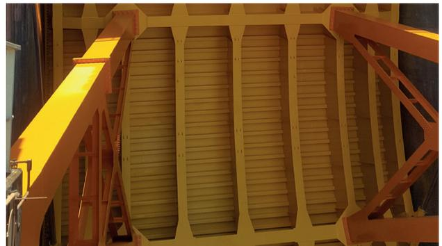
Por primera vez se realizó el repintado, ocasión en la que fue necesario el armado de andamios especiales por parte de la empresa adjudicataria CIMSA S.A. Junto al repintado se realizó el cambio de sellos de los mecanismos laterales de las compuertas.
